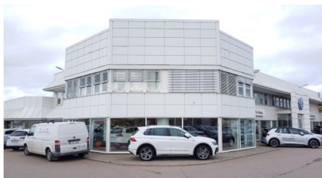
Din Bil i Helsingborg med fasadpersienn.
